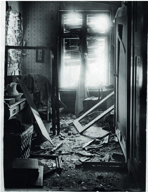
Das Vorwärts-Gebäude nach der Beschießung. Privatwohnung im III. Stock.
